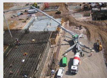
Betonierarbeiten eines Treppenturmfundaments mit einer Dicke von bis zu 7,5 Metern und einer Kubatur von ca. 11.000 m 3
