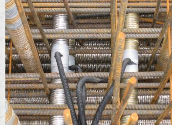
Überzug aus Spannbeton, hoher Bewehrungsgehalt, Einsatz LVB
