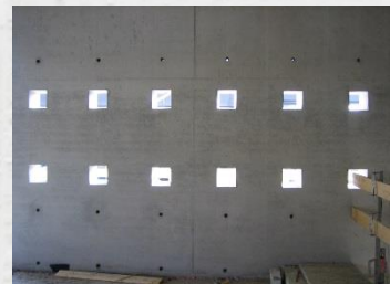
Wand mit erhöhten Sichtbetonanforderungen im Terminalbereich des Rhein-Main-Airports
