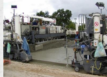
Betonfertigerzug beim Betoneinbau im Bundesfernstraßenbau
