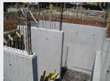
Schulung Sonderbetone – Herstellung von Sichtbeton, Beispiel Treppenhauswände
