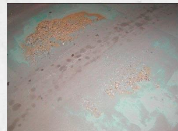
Verschleiß eines starren OS-Systems
