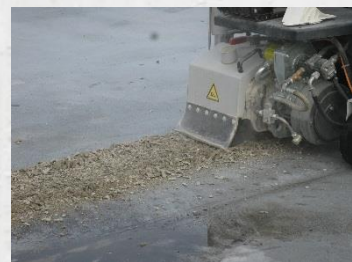
Schulung Untergrundvorbereitung - Entfernen eines rissüberbrückenden OS-Systems durch Fräsen
