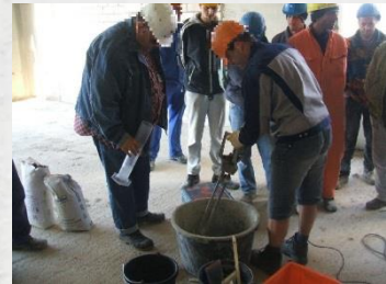
Schulung Baustellenpersonal für das fachgerechte Verarbeiten von PCC (kunststoffmodifizierter Mörtel)
