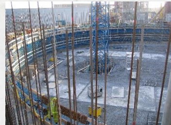
Betonierarbeiten Zementsilo in Gleitbetonbauweise bei Dublin
