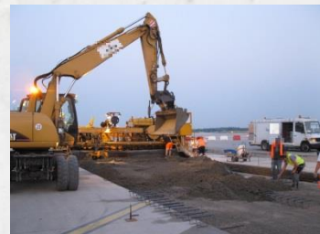
Betonierarbeiten im Vorfeldbereich Flughafen
