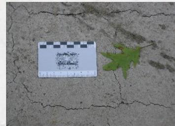
*Rissbildungen auf Deckenoberseite, zu geringe Betondeckung, verminderte Dauerhaftigkeit*
