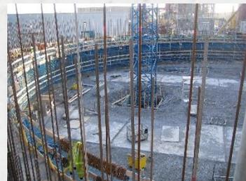
*Betonierarbeiten Zementsilo in Gleitbetonbauweise bei Dublin*
