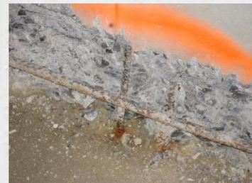
*Wandfuß im Neubau, nicht ausreichende Betondeckung, bereits sichtbare Korrosionsspuren, bei Bauqua festgestellt*
