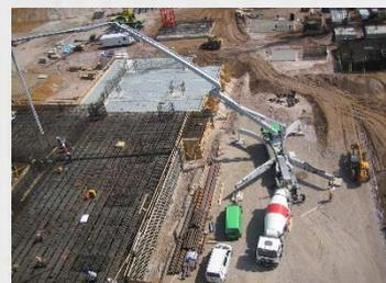
*Betonierarbeiten eines Treppenturmfundaments mit einer Dicke von bis zu 7,5 Metern und einer Kubatur von ca. 11.000 m<sup>3</sup>*
