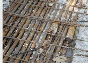
*Korrodierte Bewehrung einer Fußgängerbrücke aus Spannbeton*
