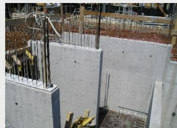
*Schulung Sonderbetone – Herstellung von Sichtbeton, Beispiel Treppenhauswände*
