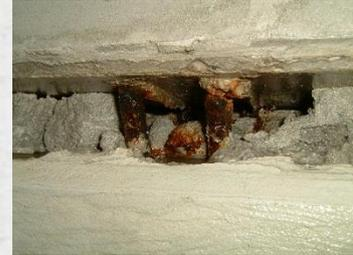
*Korrosionsspuren unter einer Brüstung, im Zuge der Inspektion erkannt*
