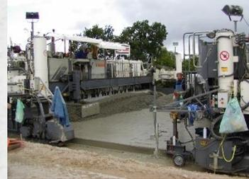
*Betonfertigerzug beim Betoneinbau im Bundesfernstraßenbau*
