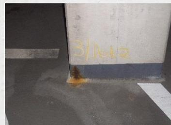
*Korrosionsspuren im Fußbereich einer Stütze im Parkhaus*
