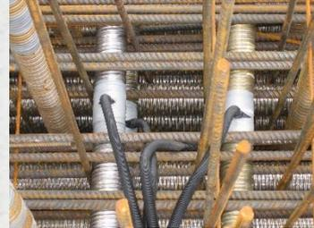
*Überzug aus Spannbeton, hoher Bewehrungsgehalt, Einsatz LVB*
